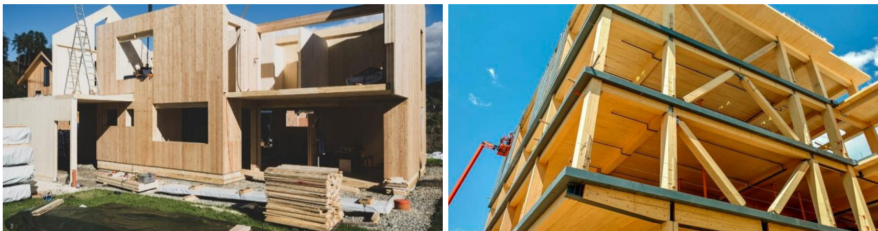
Фиг. 5. Съвременно панелно строителство от CLT панели, комбинирано строителство от дървени и стоманени елементи; източник: google.com
