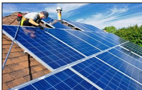
Фиг. 4. Реализация на слънчева инсталация за битово осигуряване на гореща вода и отопление
