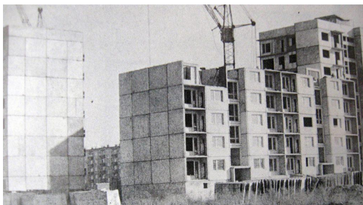
Фиг. 2. Панелни сгради, изградени в периода 1958 г. (първи пример за панелно строителство - ляво) – 1989 г; източник: google.com
